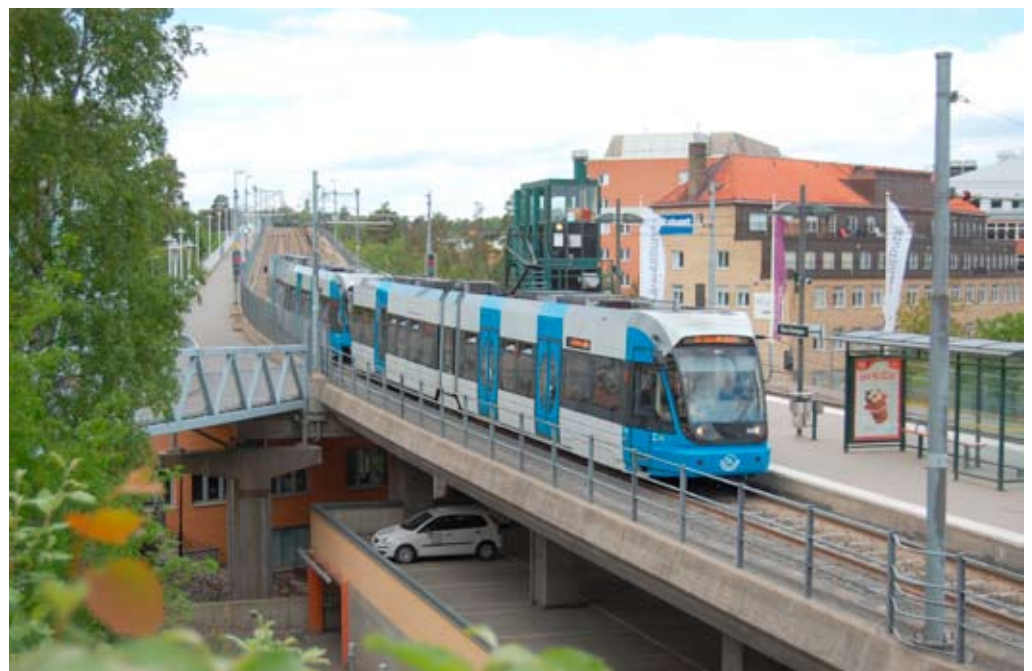
Tvärbanan als Stadtschnellbahn auf der Insel Stora Essingen, im Hintergrund die 23m hohe Brücke Richtung Alvik (Foto: Patrick Hollmann, 21.05.2011)
