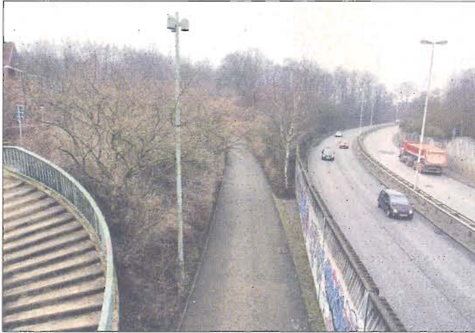
Im Bereich des Schwanenseeparks (Mitte) soll der Tunnel der Entlastungsstraße in die B502 münden.
